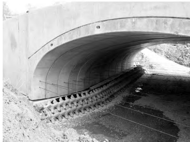
A-JACKS PARTIAL INVERT N.T.S.
