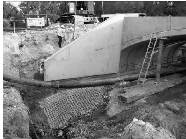
ARMORFLEX PARTIAL INVERT N.T.S.
